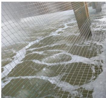
*Sistema de disolución, de presión regulable, de los gases de combustión en aguas de refrigeración. Imágenes de la torre de refrigeración de la Central Térmica de Ciclo Combinado en Castejón (cortesía de IBERDROLA).*
