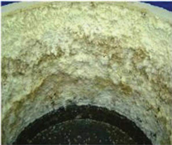
*Deposición de azufre sólido en la cabeza del digestor (cortesía de ROS ROCA INDOX CRYOENERGY).*
